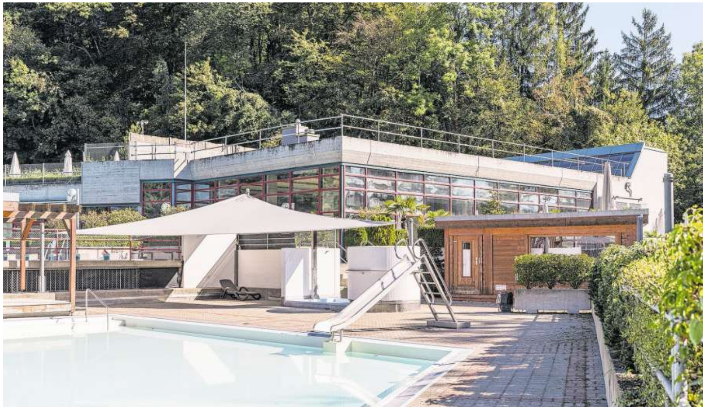
Das Hallen- und Gartenbad in Obersiggenthal. In den nächsten rund zwei Jahren wird die Anlage umfassend saniert. Bilder: Sandra Ardizzone
