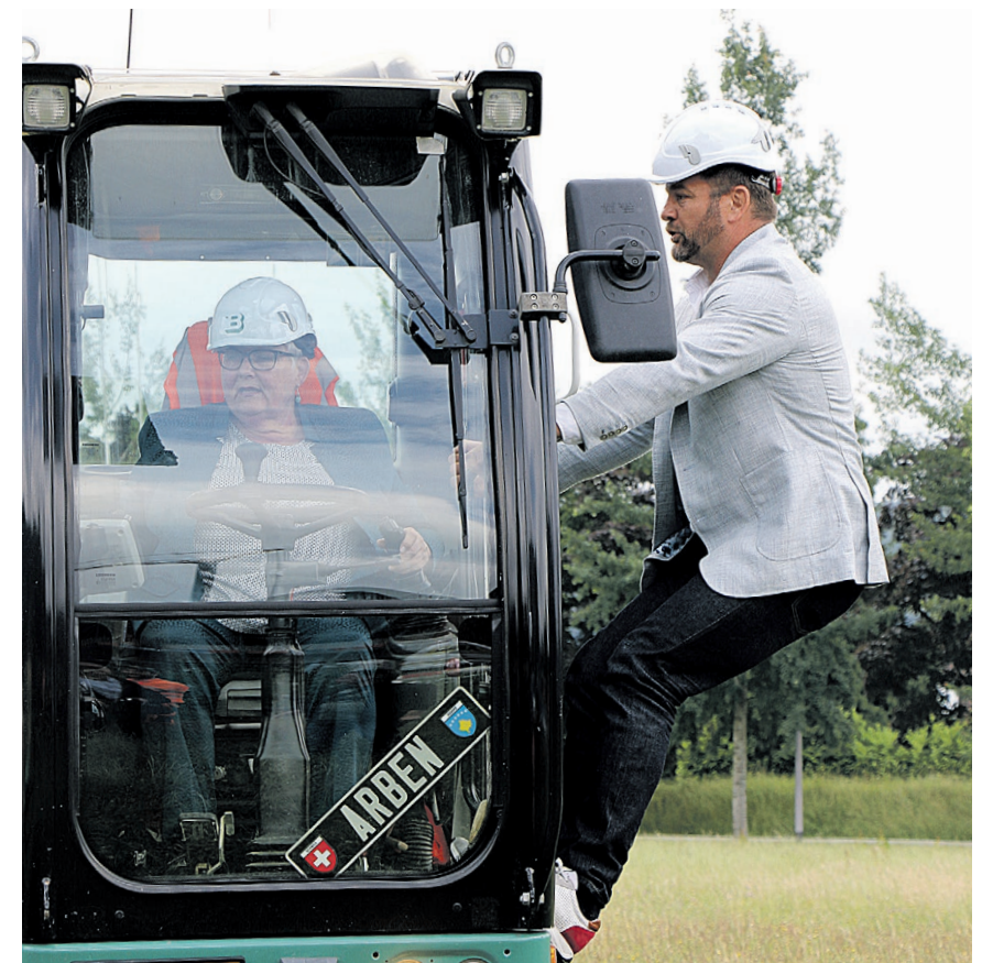
Unterstützt von «Fahrlehrer» Markus Birchmeier steuert Frau Gemeindeammann Marlène Koller den grossen Bagger.
