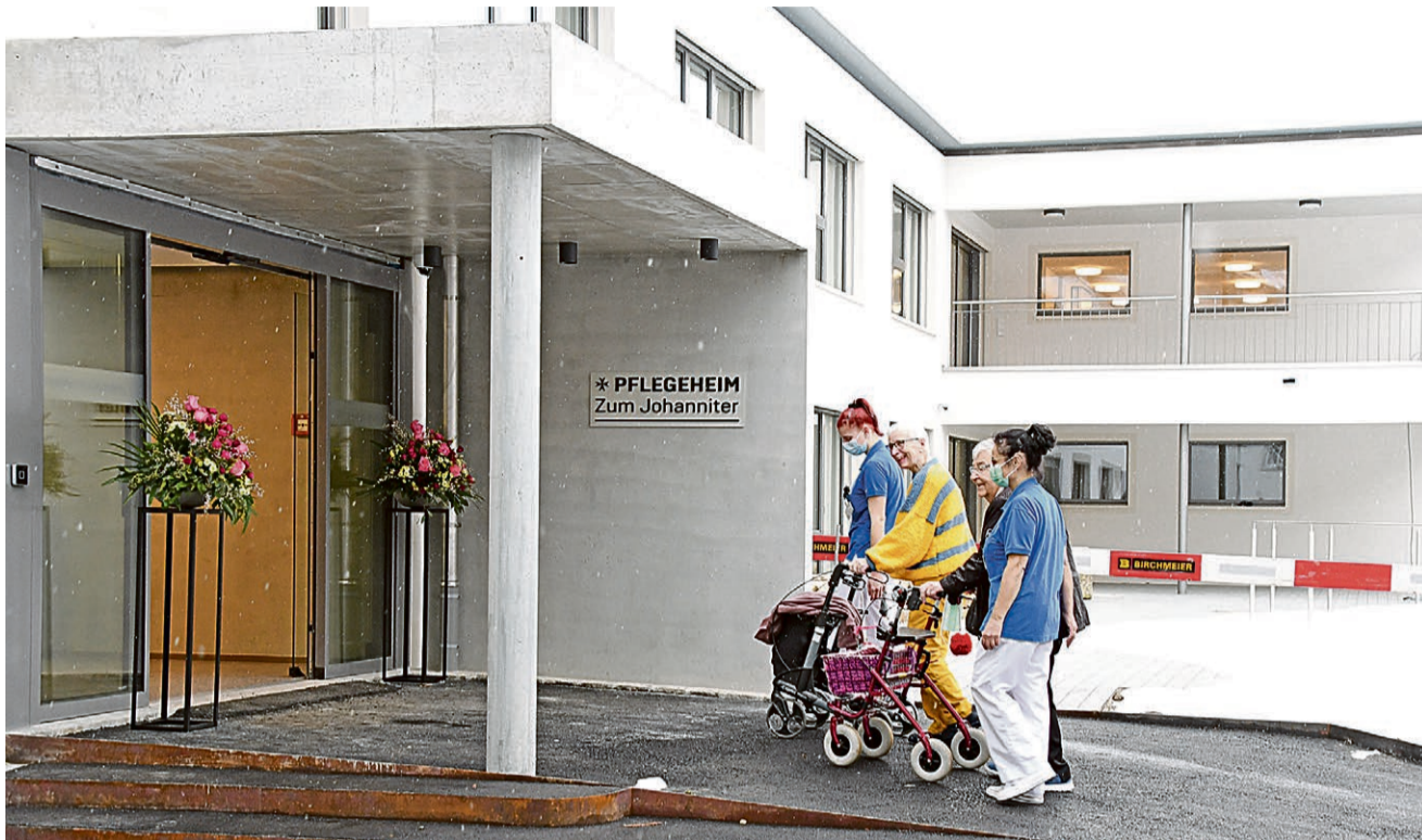
Der Eingangsbereich des neuen Pflegeheims, das den Namen «Zum Johanniter» trägt.
