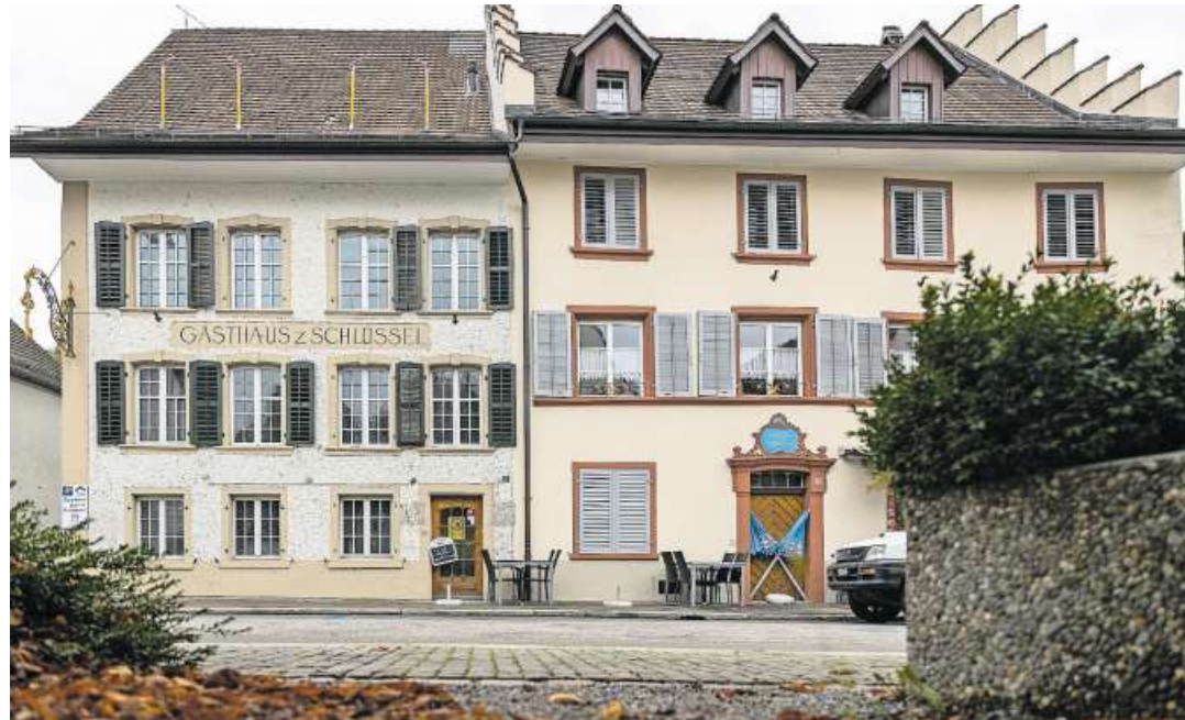
Im Erdgeschoss des Gasthofs in Bad Zurzach entstehen zwei neue Wohnungen.
