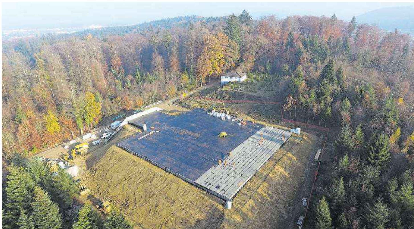
Im November 2018 laufen die Abdichtungsarbeiten. Das riesige Ausmass des Reservoirs mit zwei Kammern ist gut zu erkennen. Bild:ZVGEniwa
