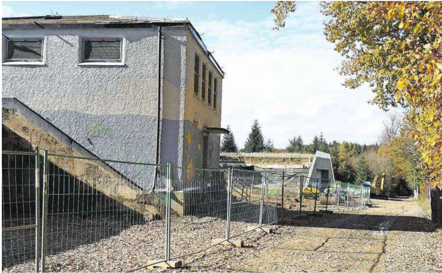
Die Rückbauarbeiten an «Gönhard 1941» (links) beweisen es: Das neue Wasserreservoir (hinten) ist in Betrieb.
