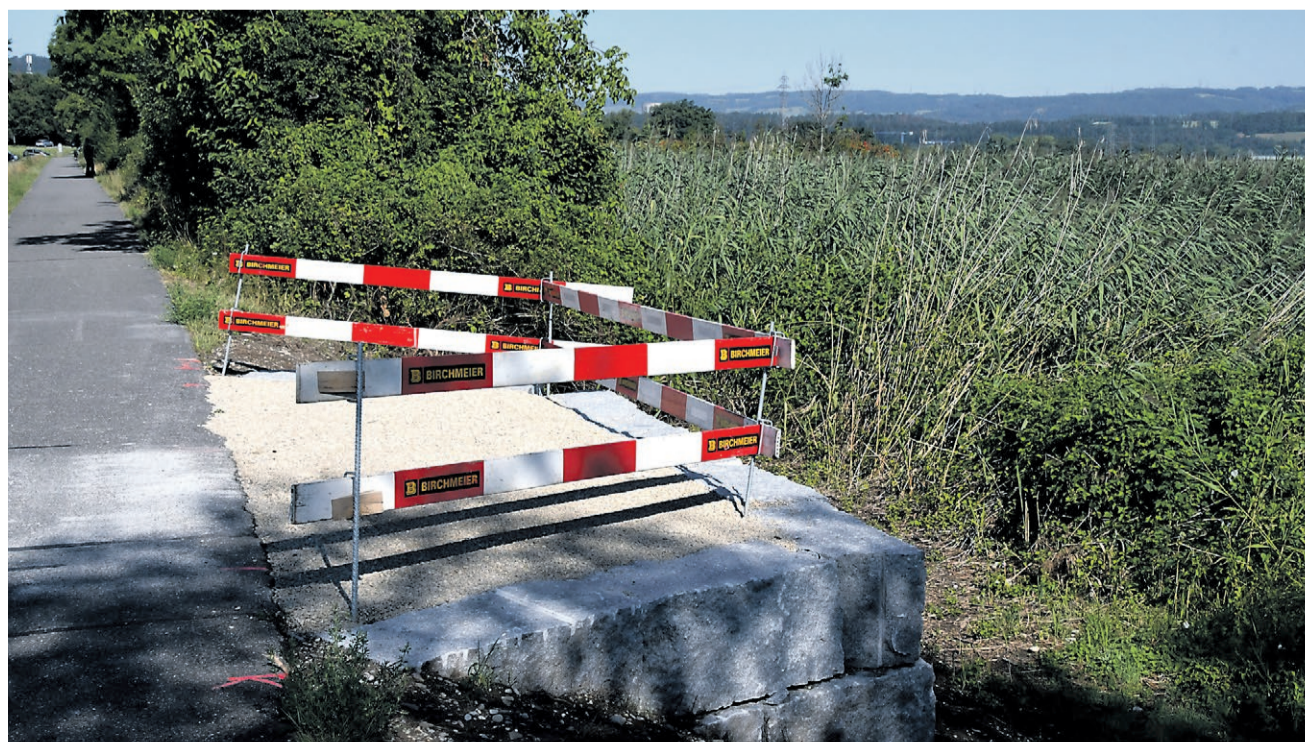
Eine Ersatzmassnahme im Rahmen der Neukonzessionierung des Kraftwerks Klingnau sind drei neue Beobachtungsplattformen auf Kleindöttinger Seite des Stausees. Sie wurden in den vergangenen Wochen erstellt.
