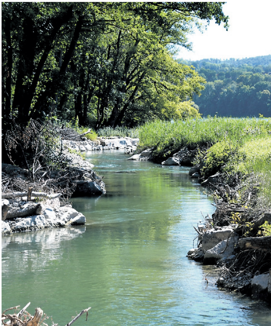
Das neue Seitengewässer im «Ifang» ist fast fertiggestellt. Es bietet wertvollen neuen Lebensraum. Die Ufer und Inseln wurden massiv verstärkt mit Blocksteinen, Faschinenbauten und Wurzelstöcken.
