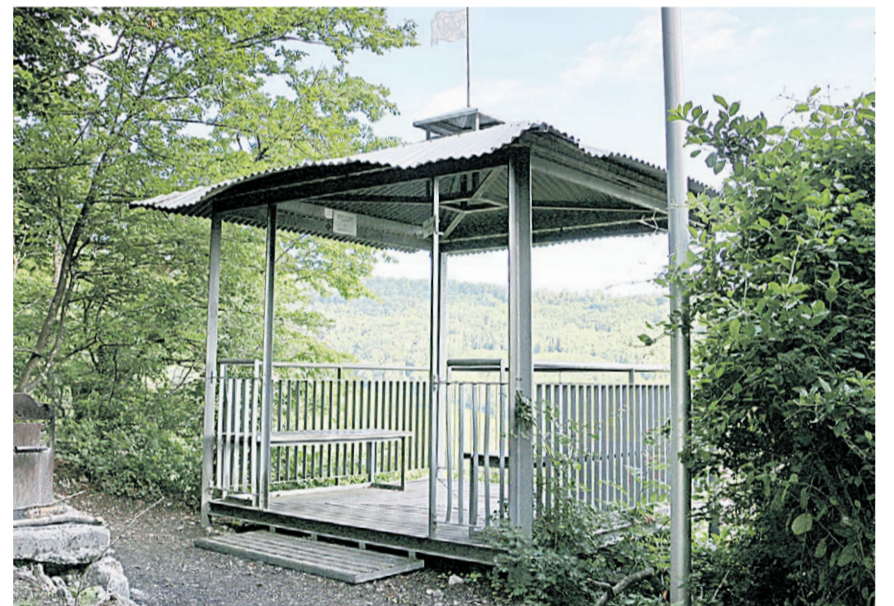
Der seit 1895 bestehende Aussichtspavillon mit Feuerstelle.
