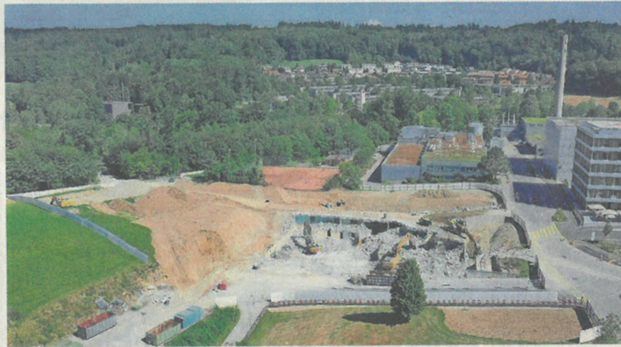
Das unterirdische Notspital in Baden-Dättwil wird bereits abgebrochen.
