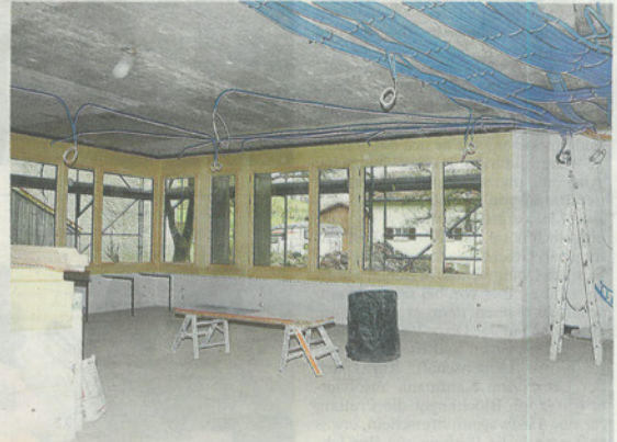
Eines der Schulzimmer mit den neuen Fenstern und vielen Elektroleitungen.
